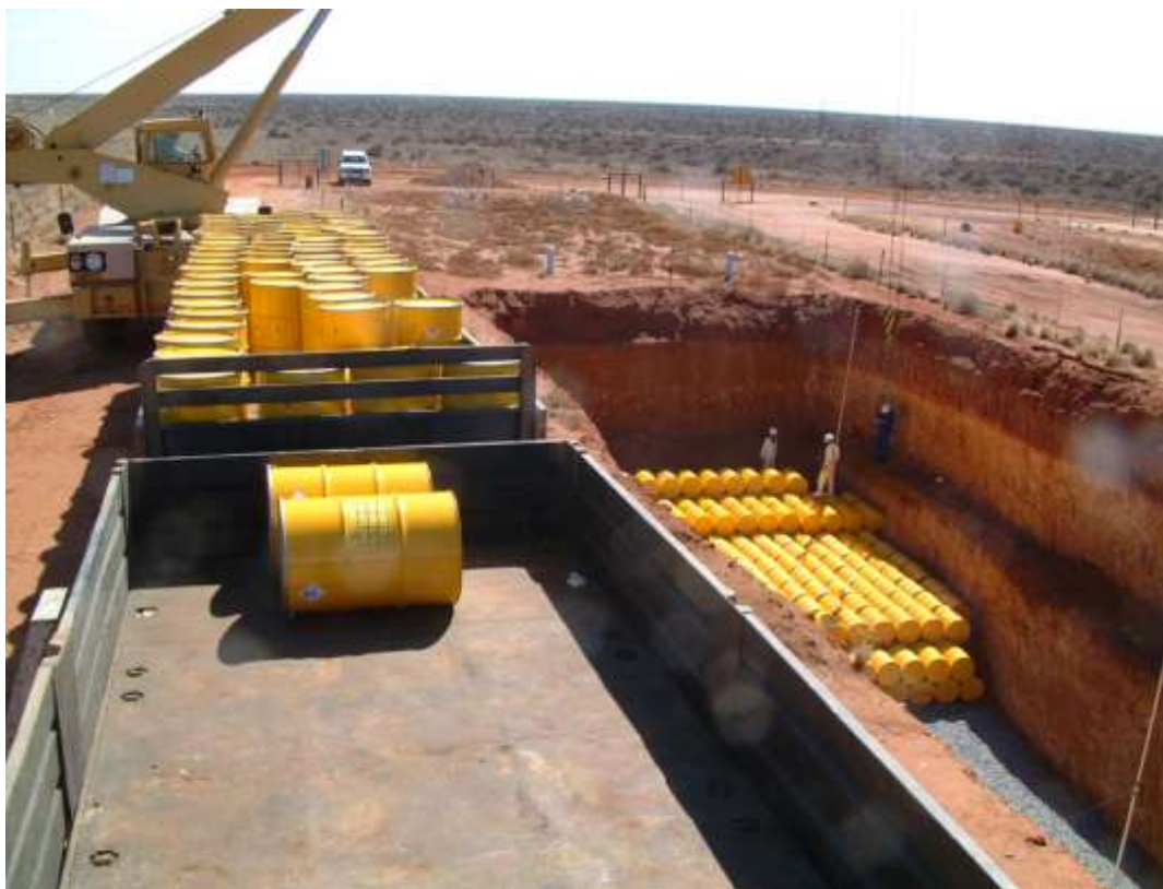
Figuur 5: Wegdoening van afvalpakkette in slote
