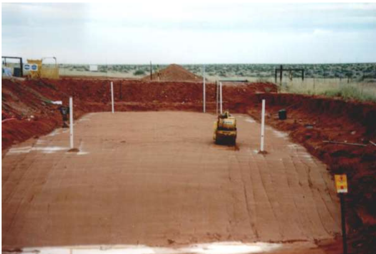
Figuur 7: Bedekking van wegdoeningsloot
